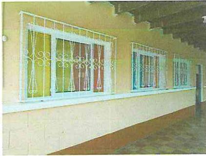
Foto1: Cambio de ventanas de paleta por ventanas de pvc.
